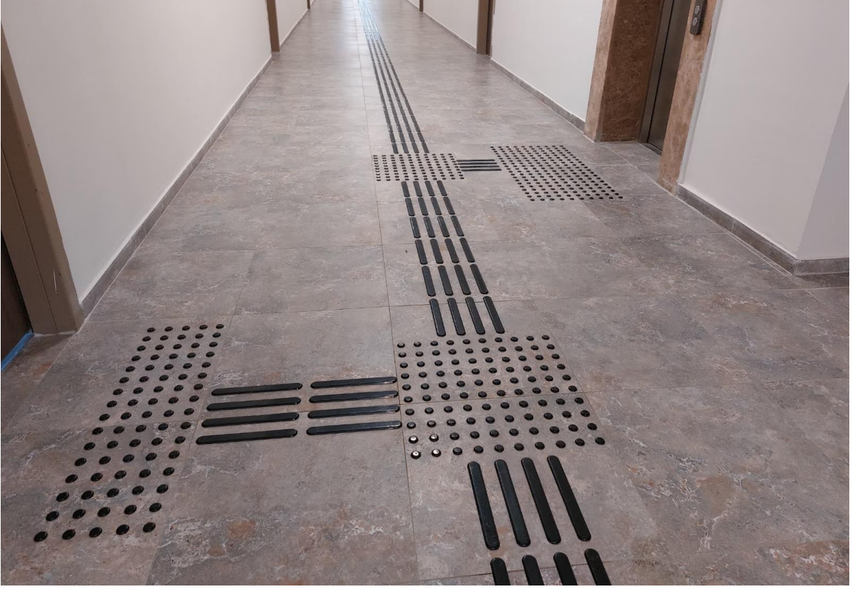
Resim.6. Eriřilebilirlik Uygulamaları ile İSG Önlemleri Kapsamında Yerleřkelerimizdeki Muhtelif Bina ve Tesislerde Bakım Onarım İři
