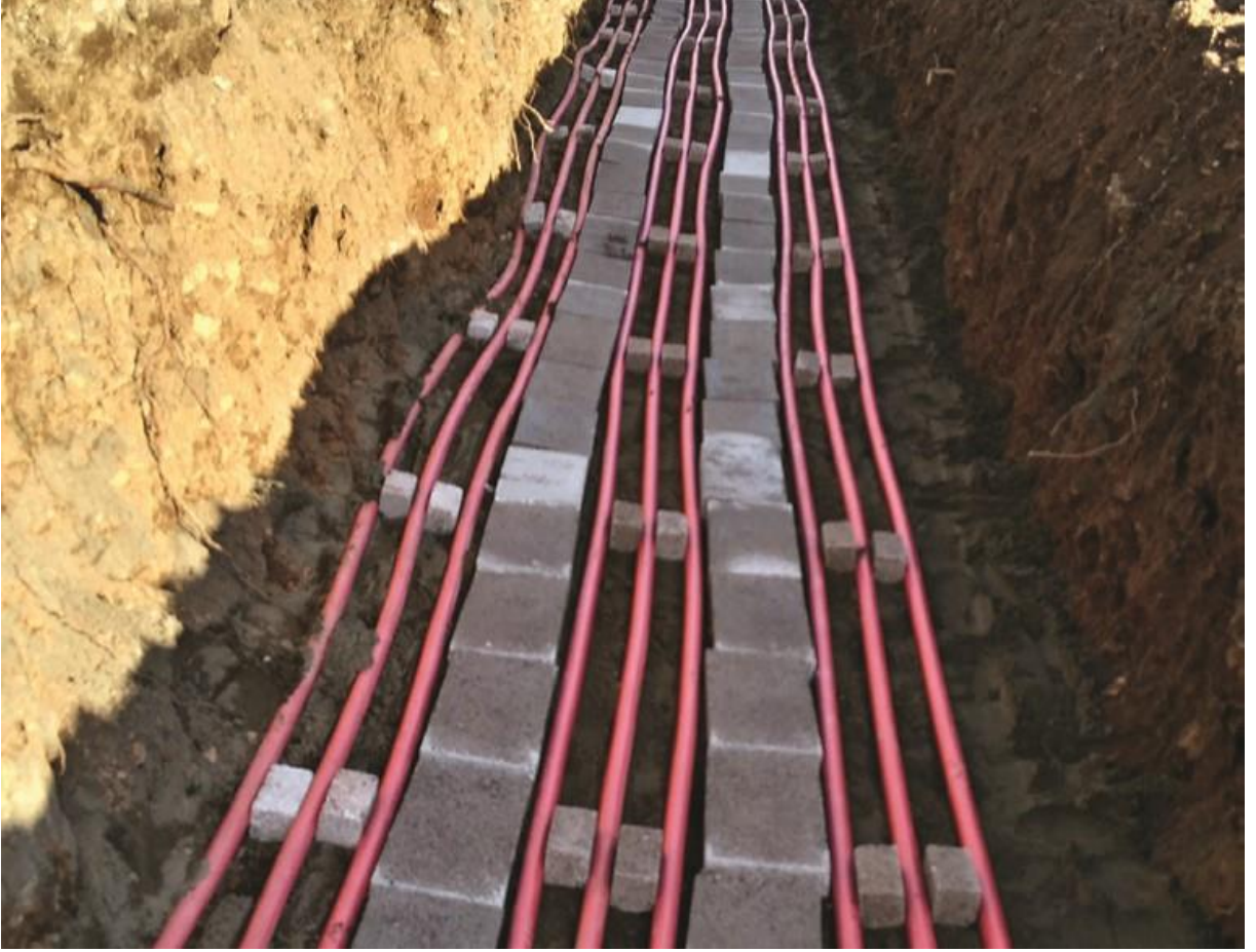
Resim.4. ALKÜ Bünyesindeki Yerleşkelerde Zayıf Akım ve Kuvvetli Akım Elektrik Altyapısı İmalatlarının Yapılması işi
