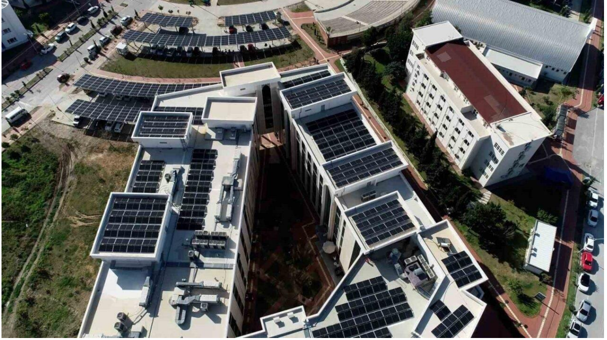
Resim.2. ALKÜ Kestel Yerleşkesi GES
