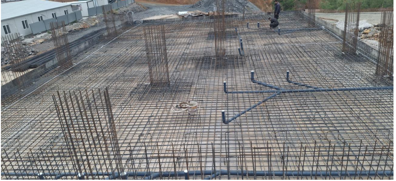
Resim.8. Rektörlük Ek Hizmet Binası Yapımı
